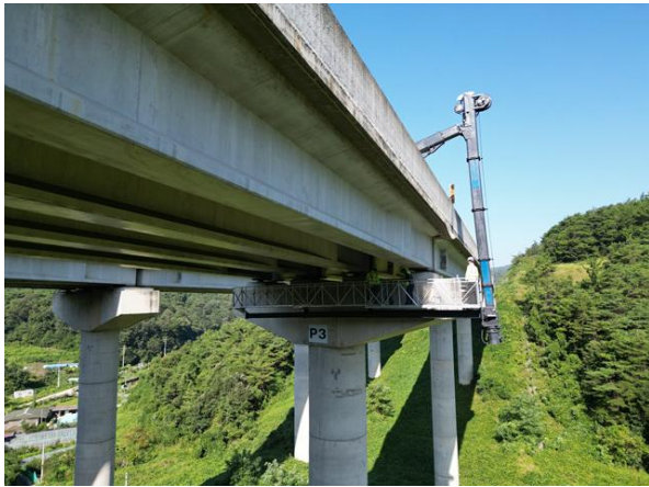
고소점검차를 이용한 근접조사
