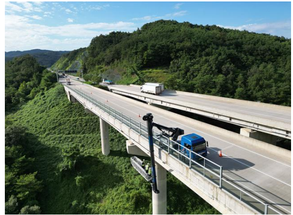
고소점검차를 이용한 근접조사
