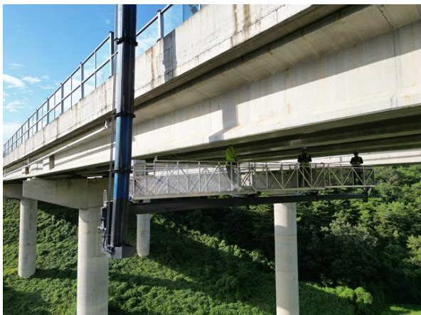
고소점검차를 이용한 근접조사
